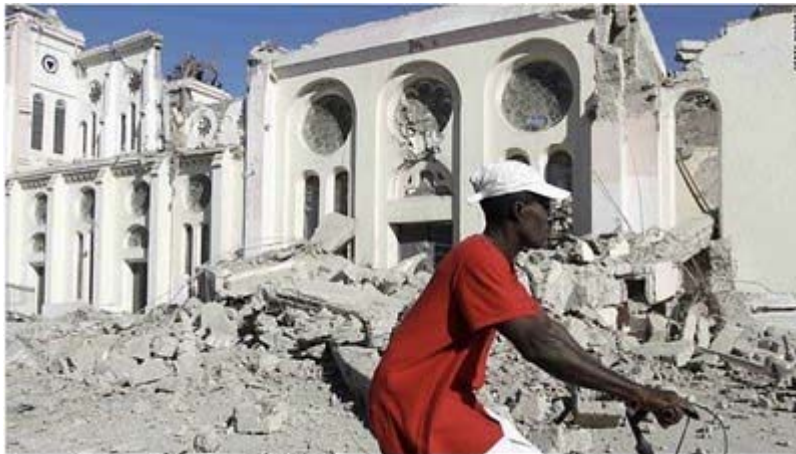
Das Bild zeigt die zerstörte Kathedrale von Port-au-Prince. Beim Einsturz der Kirche und der angrenzenden Gebäude starb auch der Erzbischof und eine bisher nicht bekannte Zahl von Klerikern, Seminaristen und Laien. (Foto: Internet)
